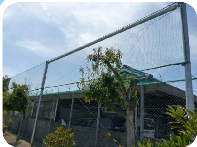
小寺第一公園フェンス設置
