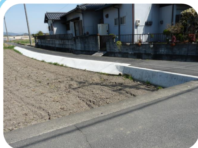
法面工事 完成
