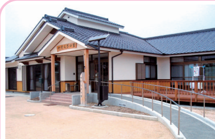
平成16年4月 総社市介護予防拠点施設やすらぎの家 竣工
