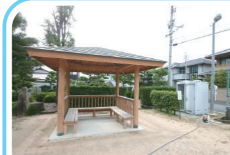
小寺地区 中島公園 建屋・トイレ・水道 整備
