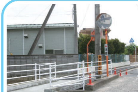
中央小学校前 通学路専用歩道 設置
