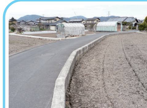
井尻野地区生活道路 拡幅
