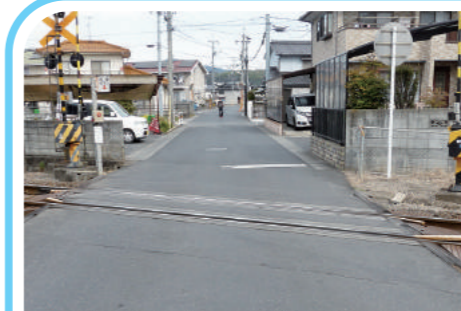
小寺地区 生活道路・踏切内 舗装
