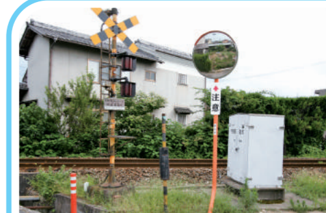
門田地区 JR所有地内 カーブミラー 設置
