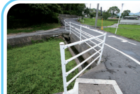
井尻野幼稚園入口付近水路 転落防止柵 設置
