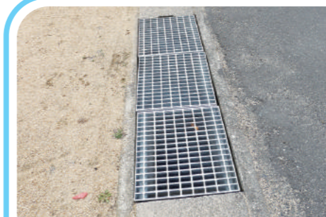
小寺地区生活道路側溝 グレーチング蓋 整備
