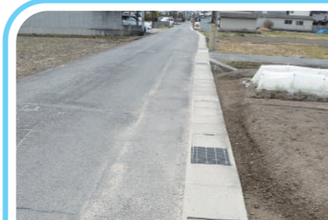
門田地区 生活道路拡幅・側溝 整備
