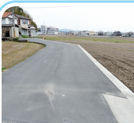
門田地区 生活道路拡幅・側溝 整備
