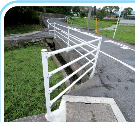
井尻野幼稚園入口付近用水路 転落防止柵 設置
