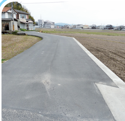
門田地区生活道路 拡幅
