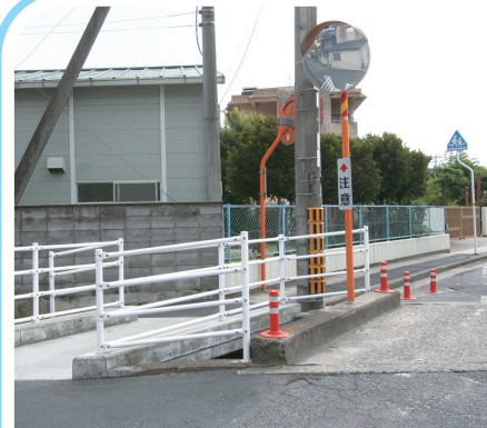
中央小学校前 通学路専用歩道 設置
