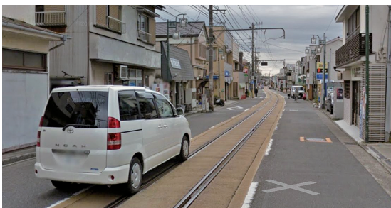
軌道の上を車両が走行 (江ノ島電鉄) 軌道法に基づく併用軌道が敷設されている。
