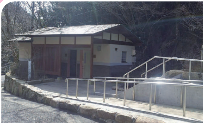
平成26年9月 豪渓 公衆トイレ 改築
